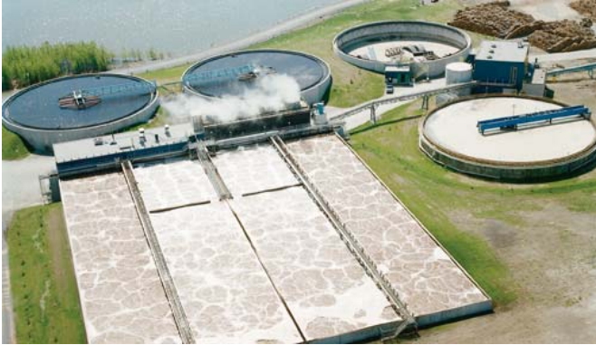
Système de traitement secondaire des effluents Trois-Rivières, Québec
