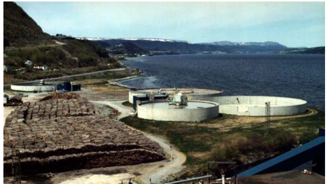
Système de traitement secondaire des effluents Corner Brook, Terre-Neuve
