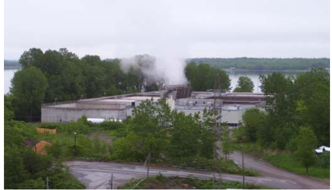
Système de traitement secondaire des effluents Kruger Wayagamack, Trois-Rivières, Québec
